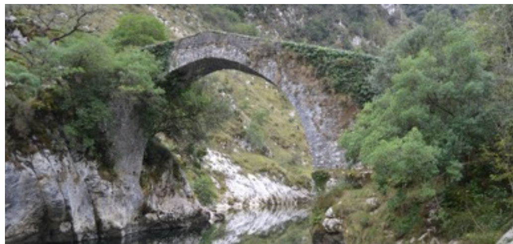
El Puente La Vidre (Peñamellera Alta), entre Trescares y Verdelláu. Imagen: Irene Sánchez
